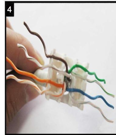
4 Kabel einführen und die einzelnen Adern nach der von Ihnen gewählten Belegungsvariante in den Kabelsortierer einführen.
